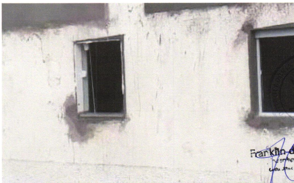
Foto 26 - JANELA DE ALUMÍNIO TIPO MAXIM-AR, COM VIDROS, BATENTE E FERRAGENS. EXCLUSIVE ALIZAR, ACABAMENTO E CONTRAMARCO. FORNECIMENTO E INSTALAÇÃO. AF_12/2019
