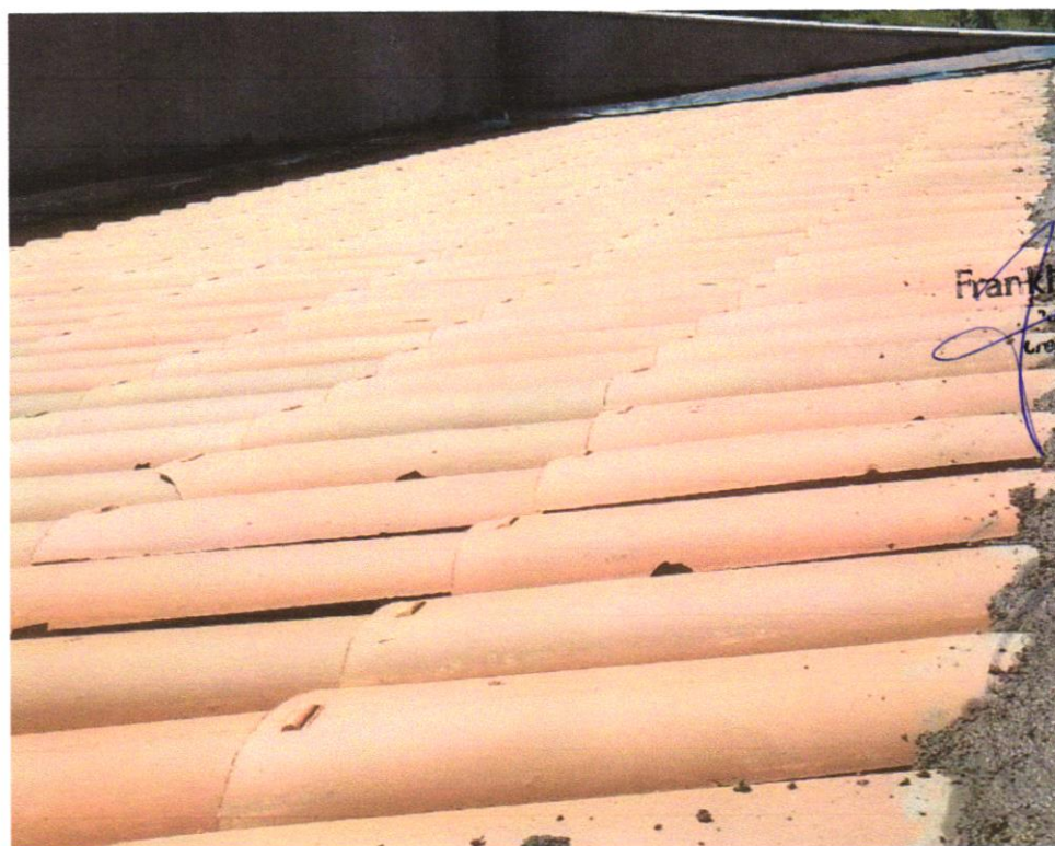
Foto 12- TELHAMENTO COM TELHA CERÂMICA CAPA-CANAL, TIPO COLONIAL, COM ATÉ 2 ÁGUAS, INCLUSO TRANSPORTE VERTICAL. AF_07/2019
