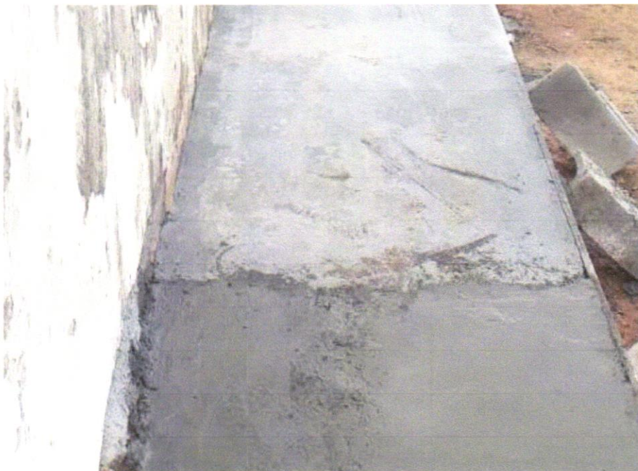
Foto 27 - Contrapiso em argamassa traço 1:4 (cimento e areia), preparo mecânico com betoneira 400 l, aplicado em áreas secas sobre laje, não aderido, acabamento não reforçado, espessura 5cm. af_07/2021
