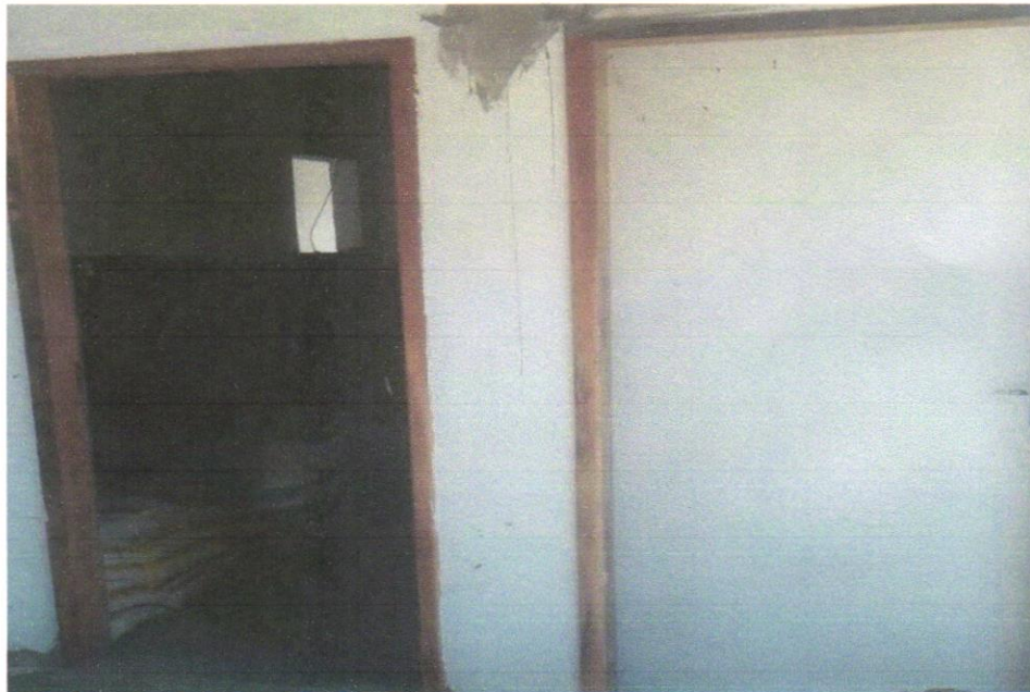
Foto 13 - KIT DE PORTA-PRONTA DE MADEIRA EM ACABAMENTO MELAMÍNICO BRANCO, FOLHA LEVE OU MÉDIA, 90X210, EXCLUSIVE FECHADURA, FIXAÇÃO COM PREENCHIMENTO TOTAL DE ESPUMA EXPANSIVA - FORNECIMENTO E INSTALAÇÃO. AF_12/2019
