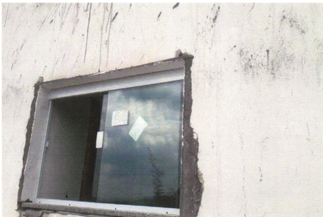
Foto 25 - JANELA DE ALUMÍNIO DE CORRER COM 2 FOLHAS PARA VIDROS, COM VIDROS, BATENTE, ACABAMENTO COM ACETATO OU BRILHANTE E FERRAGENS. EXCLUSIVE ALIZAR E CONTRAMARCO. FORNECIMENTO E INSTALAÇÃO. AF_12/2019
