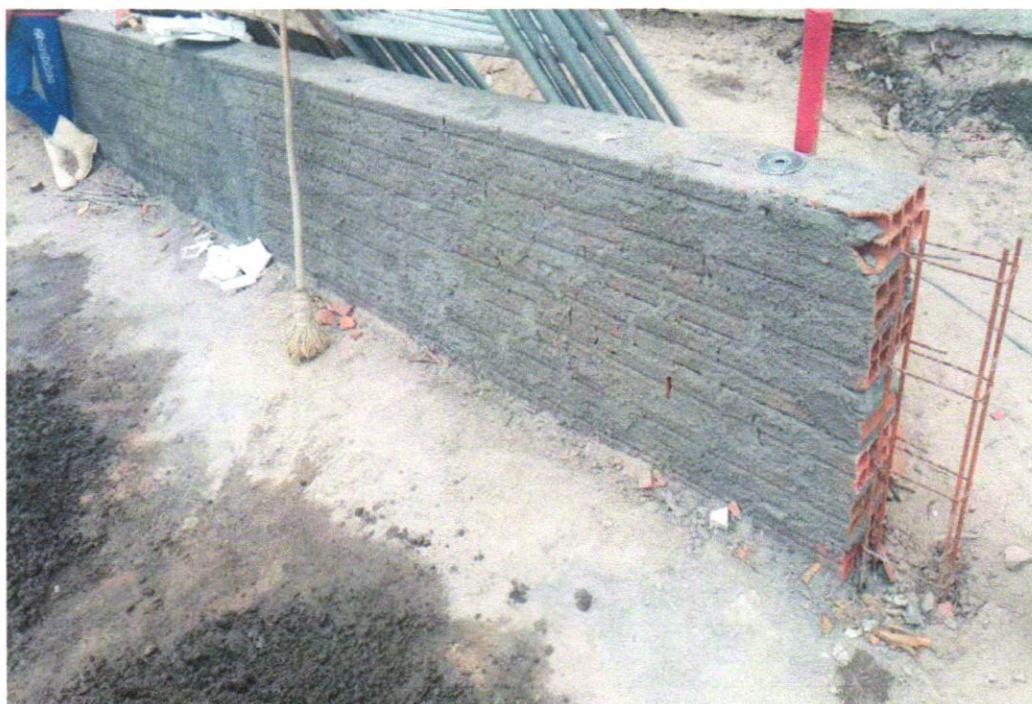
Foto 21 - CHAPISCO APLICADO EM ALVENARIA (COM PRESENÇA DE VÃOS) E ESTRUTURAS DE CONCRETO DE FACHADA, COM EQUIPAMENTO DE PROJEÇÃO. ARGAMASSA TRAÇO 1:3 COM PREPARO EM BETONEIRA 400 L. AF_06/2014
