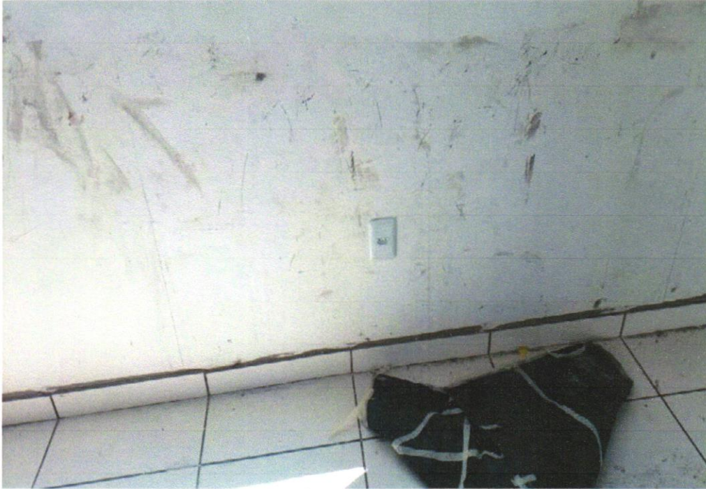
Foto 31 - TOMADA BAIXA DE EMBUTIR (1 MÓDULO), 2P+T 10 A, INCLUINDO SUPORTE E PLACA - FORNECIMENTO E INSTALAÇÃO. AF_12/2015
