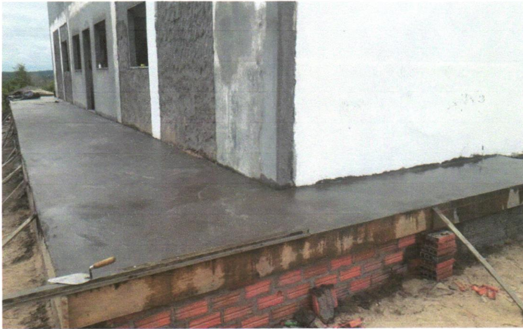
Foto 09 - EXECUÇÃO DE PASSEIO (CALÇADA) OU PISO DE CONCRETO COM CONCRETO MOLDADO IN LOCO, USINADO, ACABAMENTO CONVENCIONAL, NÃO ARMADO. AF_07/2016
