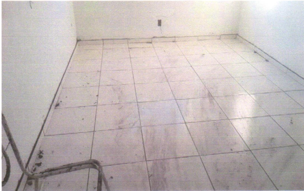
Foto 05- REVESTIMENTO CERÂMICO PARA PISO COM PLACAS TIPO ESMALTADA EXTRA DE DIMENSÕES 45X45 CM APLICADA EM AMBIENTES DE ÁREA MAIOR QUE 10 M2. AF_06/2014
