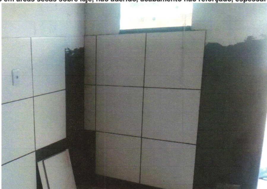
Foto 28 - REVESTIMENTO CERÂMICO PARA PAREDES INTERNAS COM PLACAS TIPO ESMALTADA EXTRA DE DIMENSÕES 33X45 CM APLICADAS EM AMBIENTES DE ÁREA MAIOR QUE 5 M² A MEIA ALTURA DAS PAREDES. AF_06/2014
