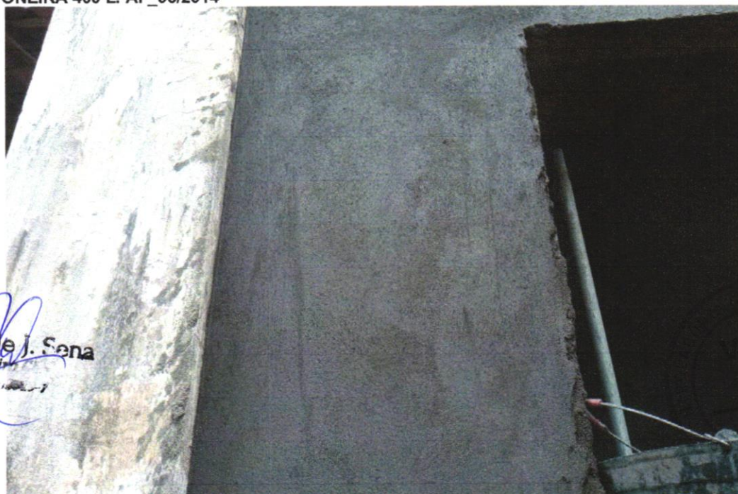
Foto 22 - MASSA ÚNICA, PARA RECEBIMENTO DE PINTURA OU CERÂMICA, ARGAMASSA INDUSTRIALIZADA, PREPARO MECÂNICO, APLICADO COM EQUIPAMENTO DE MISTURA E PROJEÇÃO DE 1,5 M3/H EM FACES INTERNAS DE PAREDES, ESPESURA DE 5MM, SEM EXECUÇÃO DE TALISCAS. AF_06/2014
