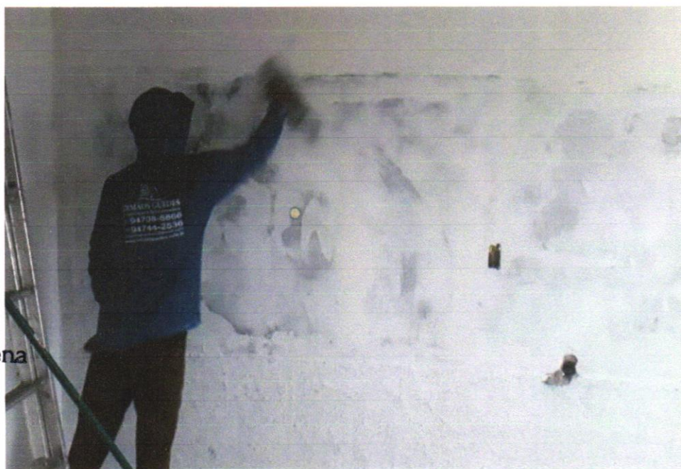
FOTO 01 – Preparo de superfície com lixamento de paredes e tetos
