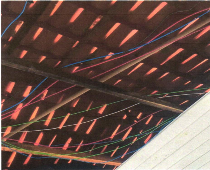
Foto 17 - CABO DE COBRE FLEXÍVEL ISOLADO, 1,5 MM 2 , ANTI-CHAMA 450/750 V, PARA CIRCUITOS TERMINAIS - FORNECIMENTO E INSTALAÇÃO. AF_12/2015
