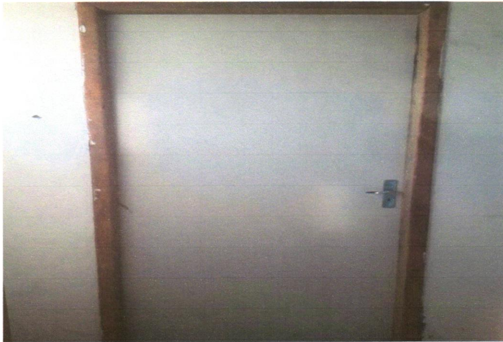
Foto 15 - KIT DE PORTA-PRONTA DE MADEIRA EM ACABAMENTO MELAMÍNICO BRANCO, FOLHA LEVE OU MÉDIA, 80X210CM, EXCLUSIVE FECHADURA, FIXAÇÃO COM PREENCHIMENTO PARCIAL DE ESPUMA EXPANSIVA - FORNECIMENTO E INSTALAÇÃO. AF_12/2019
